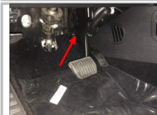
3.4、驾驶室线束穿线位置；
