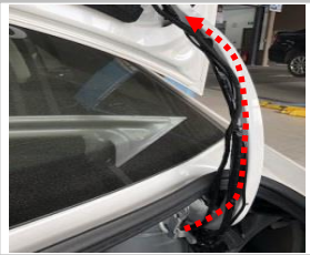
3.3 将开关线、门锁线分支沿右侧弯杆布置到尾门上方。
