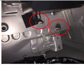
2.11 T型螺栓安装位置及状态
