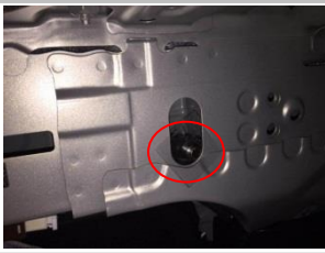
2.10 T型螺栓安装位置及状态
