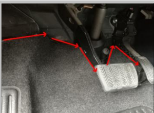
2.2 线束穿过时注意在脚刹下面的线束注意隐藏到地毯里面；避免线束悬空造成掉落在刹车油门踏板上的风险；
