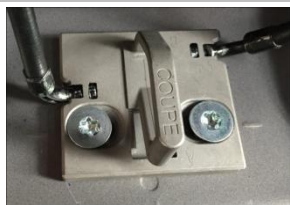
5.4 用两颗螺钉拧紧； 注意 ：安装时根据开关门的缝隙上下移动锁扣调整至合适位置；
