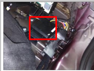
3.2 安装 ECU： 安装在尾箱右侧内部钣金，固定好防止松动
