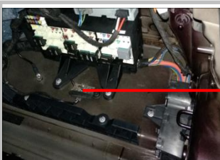
3.8 撑杆负极： 在尾箱右车拆开盖板，在内部看到原车螺栓柱
